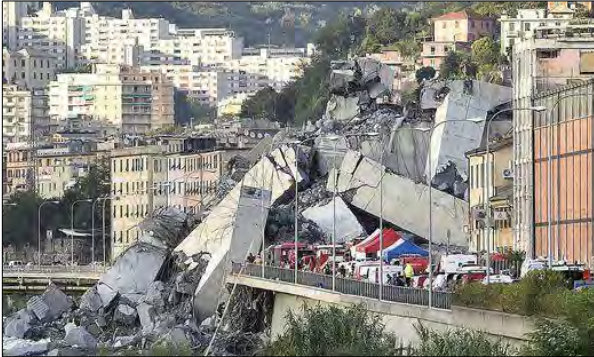
Eingestürzte Brücke Genua
